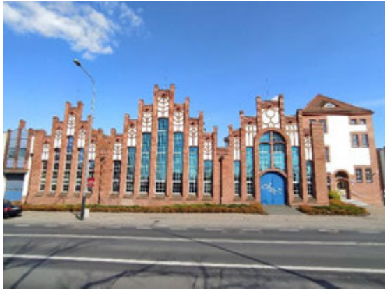
Fot. 12. Zabytkowa przepompownia ścieków Autor: D. Abramowicz
